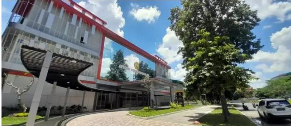
Gambar 6. Gedung kewirausahaan Unej
